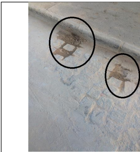
Foto 3 – Desníveis no calçamento em paralelepípedo. Teolândia/BA, 13 de julho de 2016.
