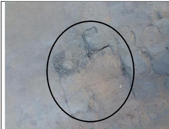
Foto 1 – Desnível no calçamento em paralelepípedo. Teolândia/BA, 13 de julho de 2016.
