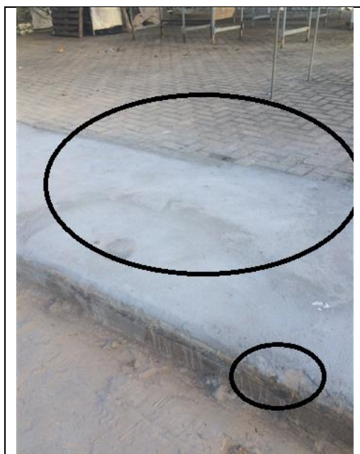
Foto 3 – Desníveis no calçamento em paralelepípedo. Teolândia/BA, 13 de julho de 2016.
