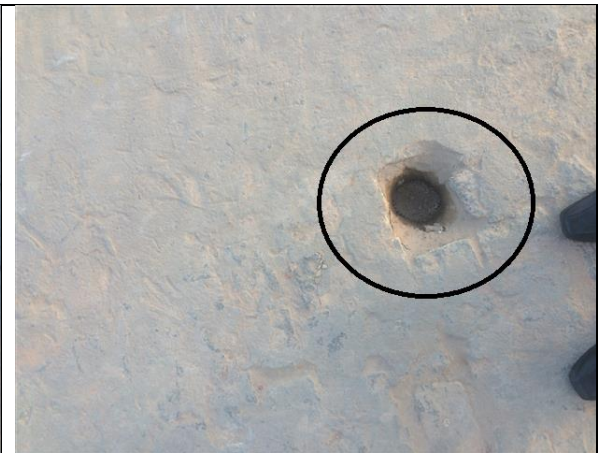
Foto 2 – Buraco no calçamento em paralelepípedo. Teolândia/BA, 13 de julho de 2016.
