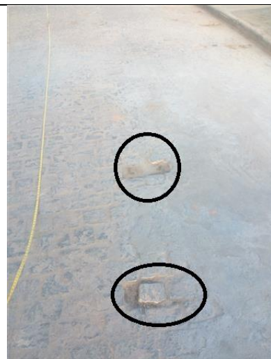
Foto 4 – Buracos no calçamento em paralelepípedo. Teolândia/BA, 13 de julho de 2016.
